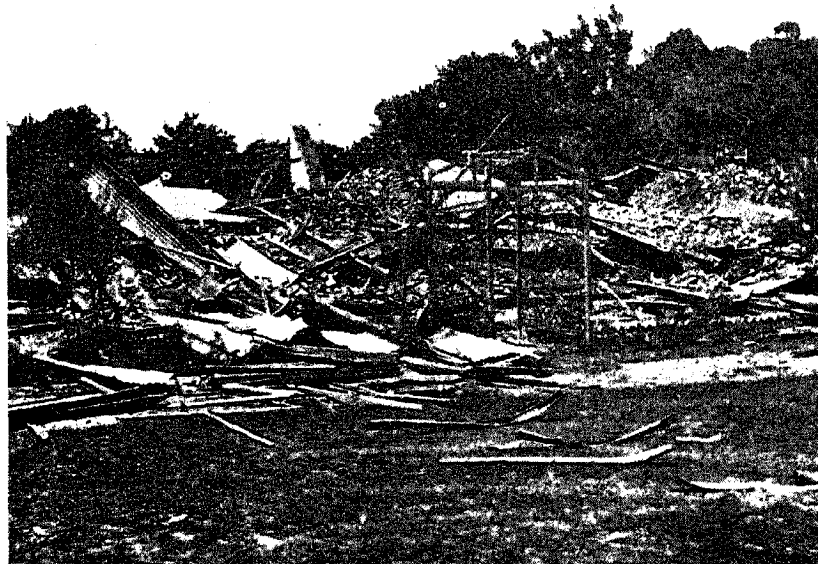
Fig. 2. The Dak Bungalow, Quetta.
